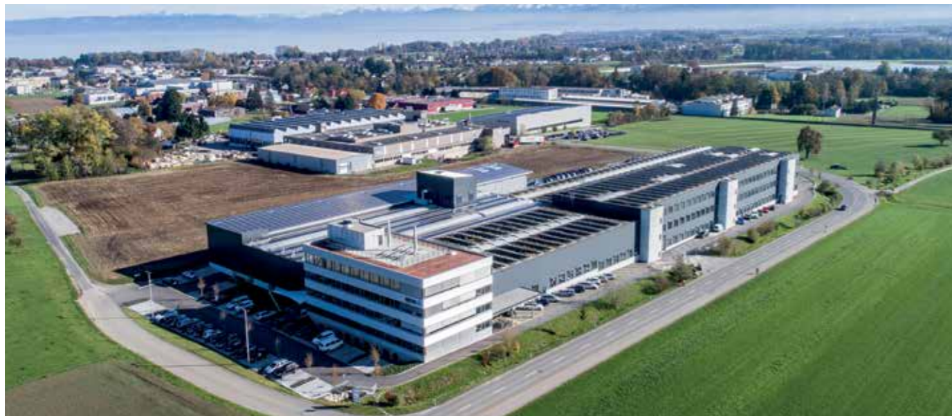
Superschwergewicht: Produktionshallen mit Einzellasten bis 200 t, Recktunnel im UG bis 800 t, Portalkran bis 150 t, Nutzlast OG bis 1'200 kg/m 2
