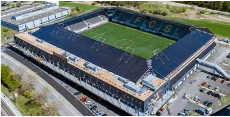
1. Platz – Methabau: Stadion LIPO Park.
