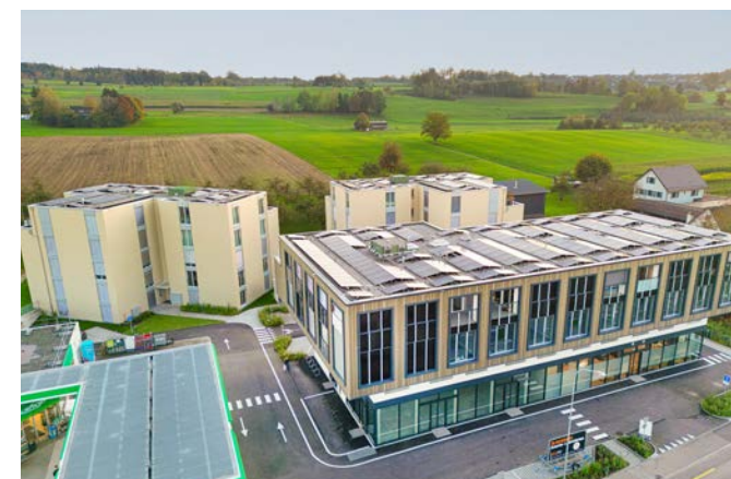
Im Vordergrund das Wohn- und Geschäftshaus mit Hotelbetrieb, Büro- und Gewerbeflächen sowie Wohnungen. Die Abfahrt der benachbarten Tankstelle wird über unser Areal geführt.
