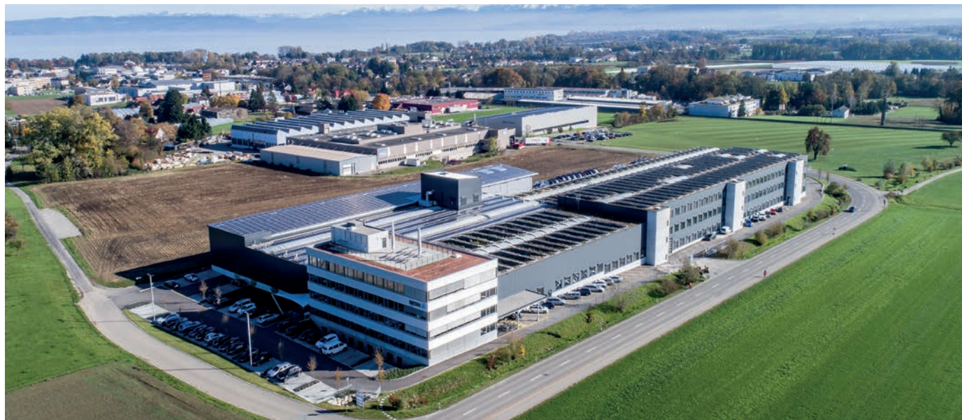
Superschwergewicht: Produktionshallen mit Einzellasten bis 200 t, Recktunnel im UG bis 800 t, Portalkran bis 150 t, Nutzlast OG bis 1'200 kg/m²
