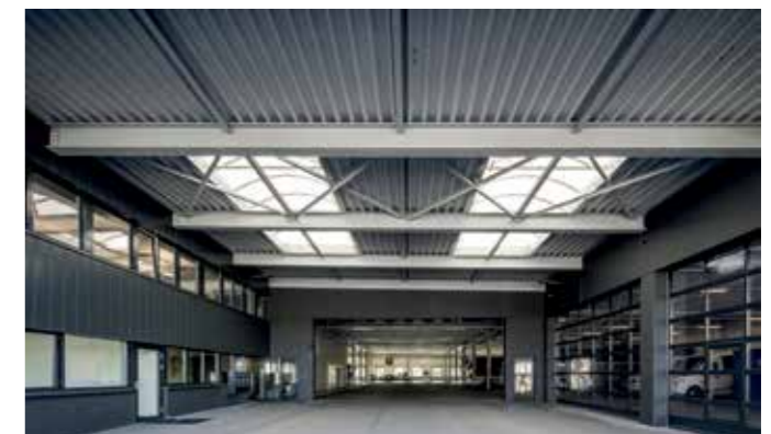
Innovativ: Statt Geschoss für Geschoss von unten nach oben zu bauen, haben wir drei Geschosse von hinten nach vorne realisiert.
