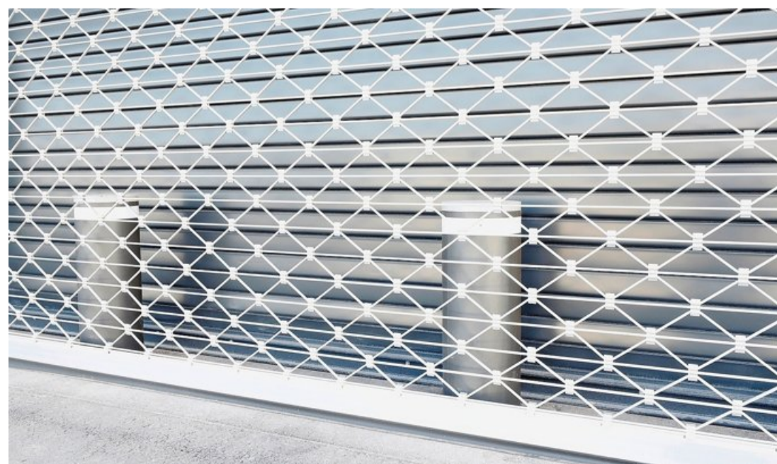
Die Tore zum Hochsicherheitslager sind mehrfach gesichert. Die massiven Poller entmutigen jeden Rammbockeinbrecher.
