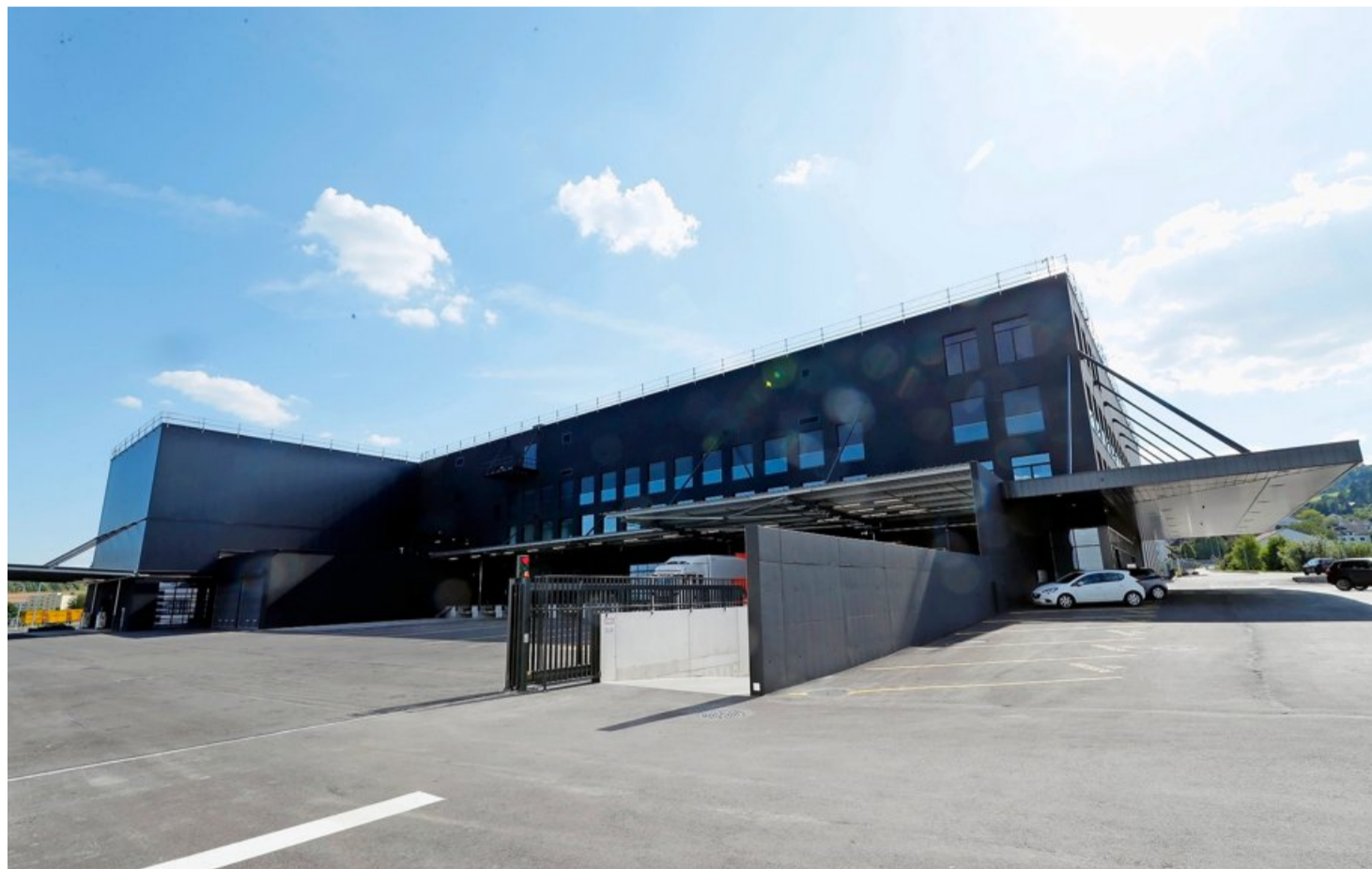
Der Welti-Furrer-Neubau an der Biologiestrasse in Dielsdorf weist ein Hochsicherheitslager für Kunstwerke, das landesweit modernste Containerlager der Schweiz und einen ausbaubaren Self-Storage-Bereich auf.
